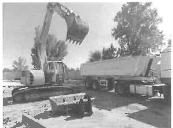
Chargement des terres impactées pour leur envoi en centre de traitement
