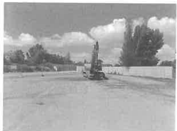
Remise en état du site – fin des travaux (21/07/2014)
