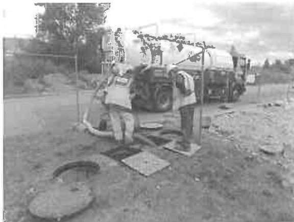
Pompage des eaux impactées du séparateur à hydrocarbures
