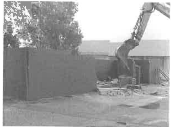
Démolition du muret entourant le réservoir aérien et des bétons
