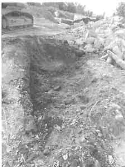
Zone impactée au droit de l'aire de dépotage
