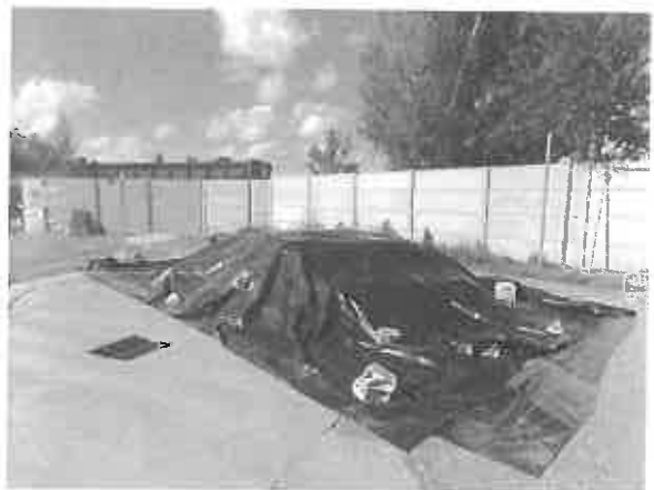
Zone de stockage provisoire des terres impactées au Nord du site (08/07/2014)
