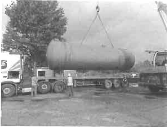
Extraction et évacuation du réservoir aérien de 80 m 3 GO (R1)
