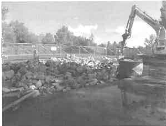
Démolition du béton au droit des pistes de distribution
