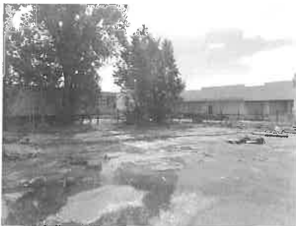
Remblaiement de la fouille du réservoir (R2) avec les terres excavées non impactées
