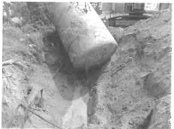
Extraction du réservoir enterré de 20 m 3 GO (R2)
